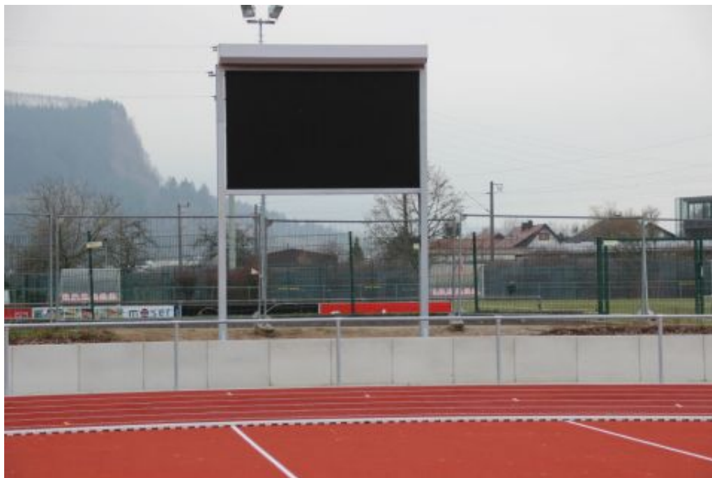
der LED-Anzeigetafel ist fertig
